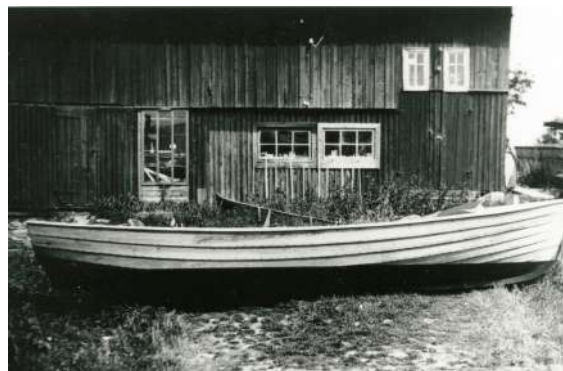
Kuuttilan veneveistämö 1932-33, sauna sijaitsi mahdollisesti rakennuksen oikeassa päädyssä. Uudenkaupungin museo
